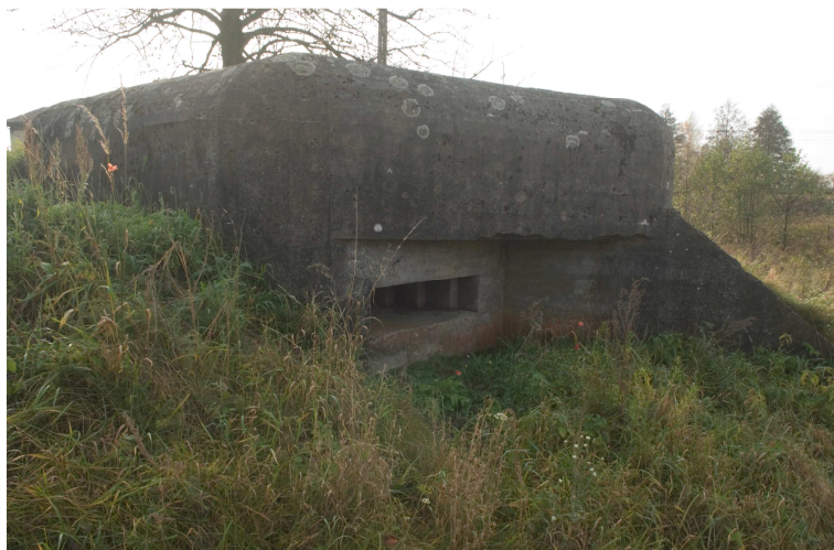
Schron na linii umocnień Przedmościa Bydgoskiego
