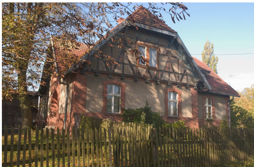
Budynek dawnej szkoły
