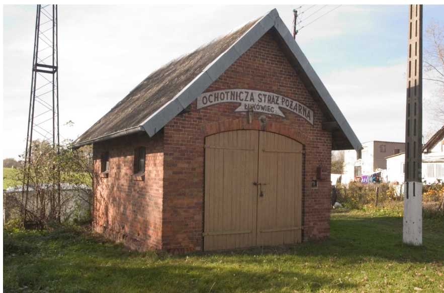
Budynek remizy OSP
