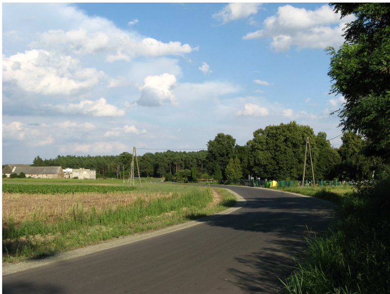
Zmodernizowana droga w Dąbrówce Nowej
