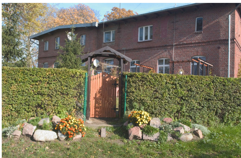
Budynek starej szkoły
