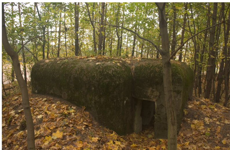
Element systemu umocnień Przedmościa Bydgoskiego
