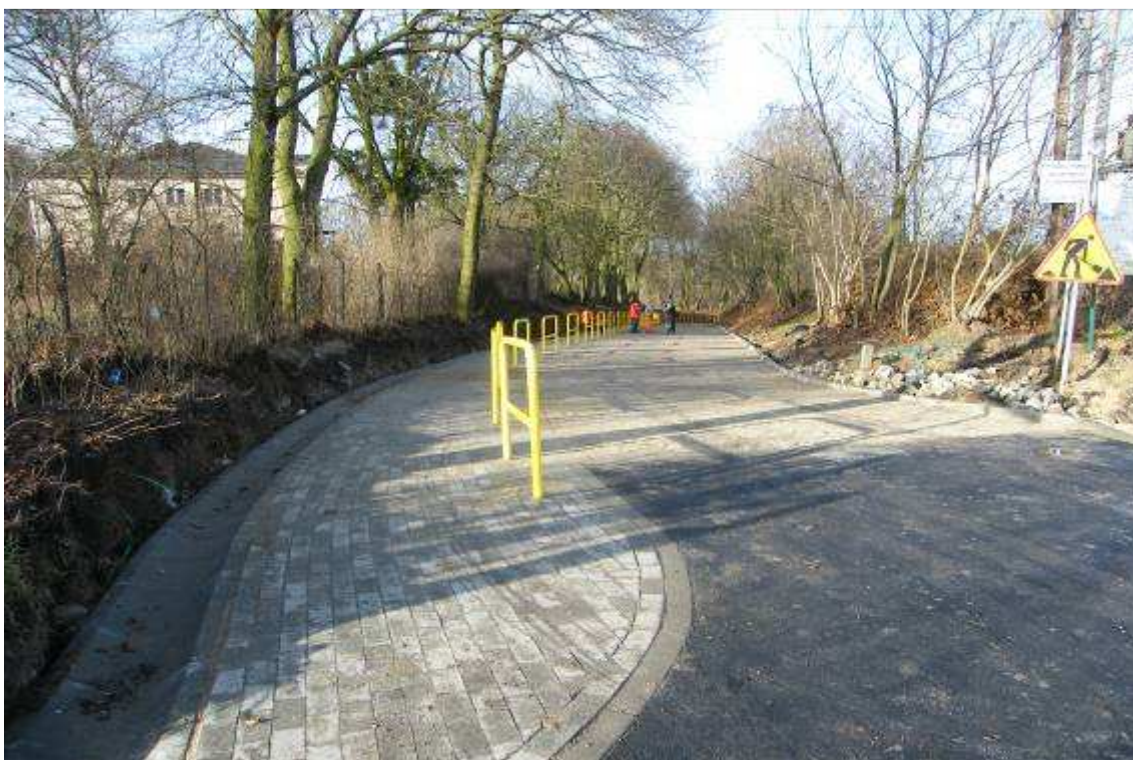
Fot. 66. Połączenie odcinka drogi
