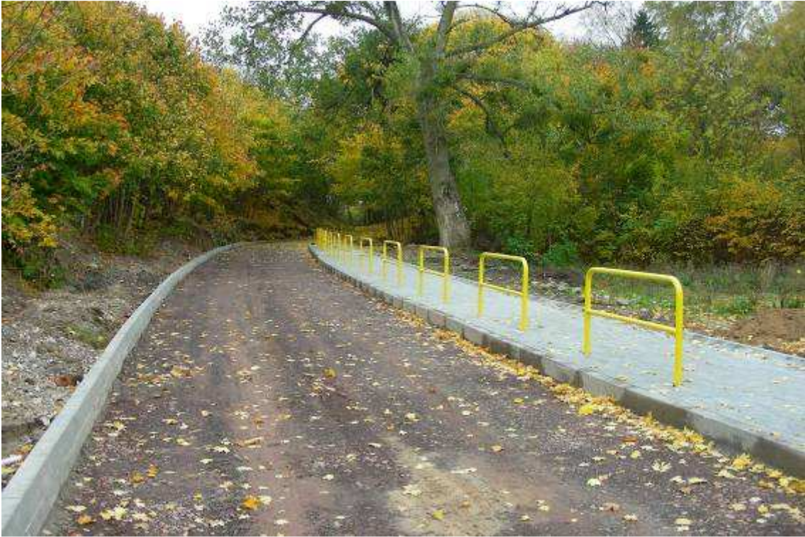
Fot. 63. Przebudowany odcinek drogi gminnej (widok od strony jeziora w czasie budowy chodnika i drogi)
