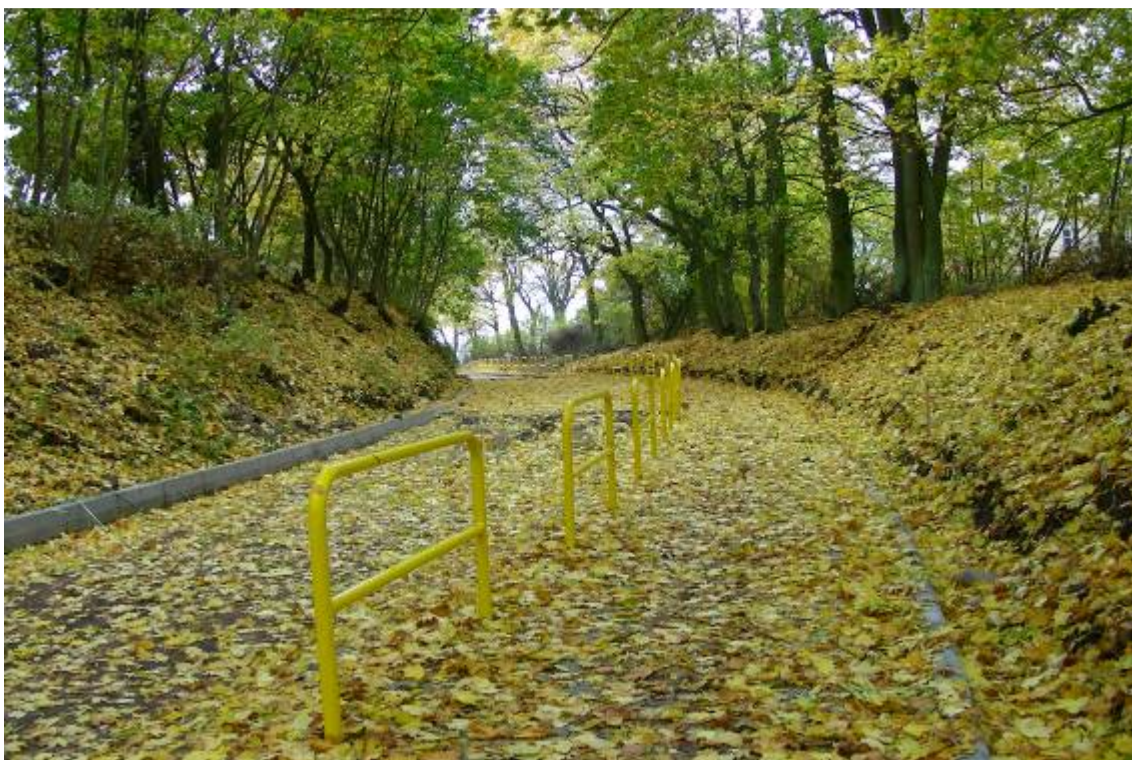
Fot. 65. Teren budowy drogi z kamienia oraz ciąg pieszo rowerowy z kostki brukowej
