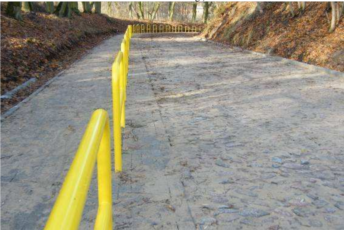
Fot. 64. Przebudowany odcinek drogi z kamienia oraz ciąg pieszo - rowerowy z kostki brukowej
