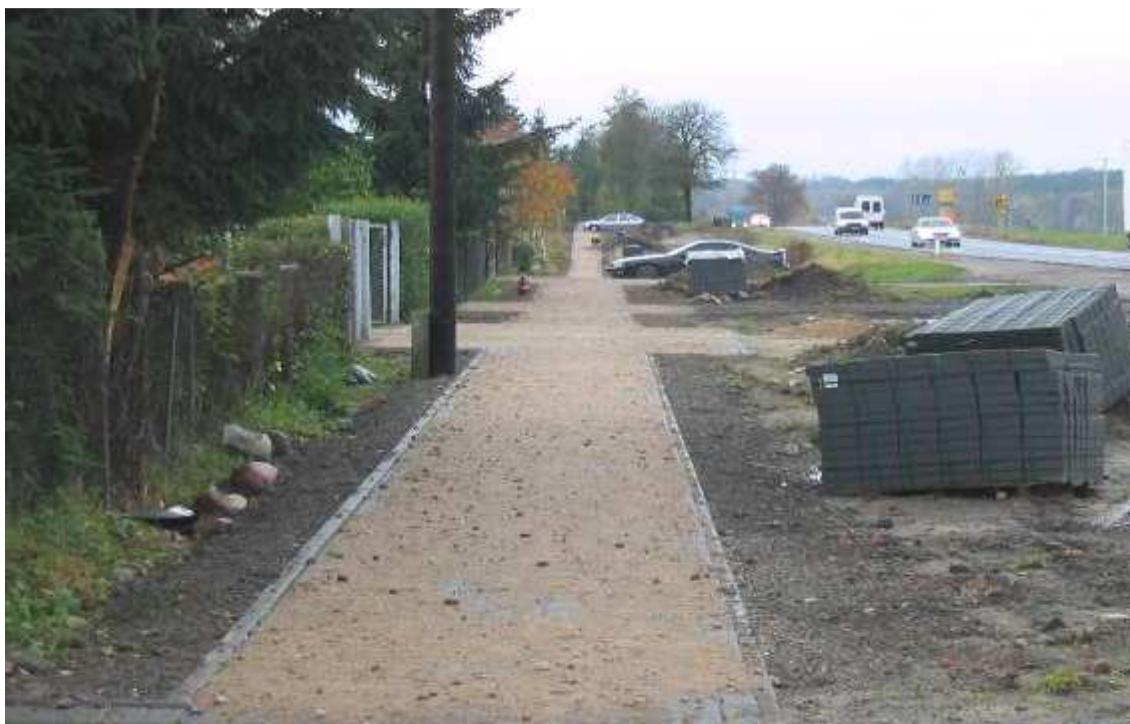
Fot. 30. Budowa odcinka chodnika przy drodze krajowej nr 10 w Kruszynie (plac budowy)
