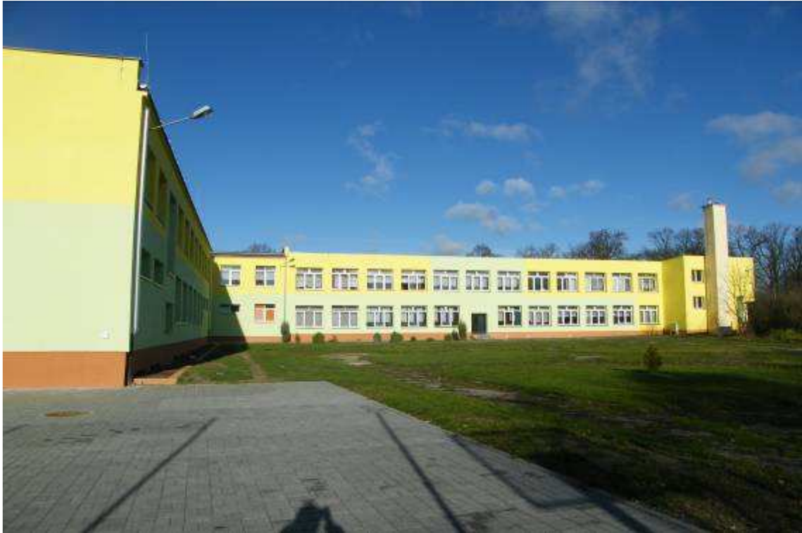
Fot. 46. Widok na budynek szkoły od strony boiska
