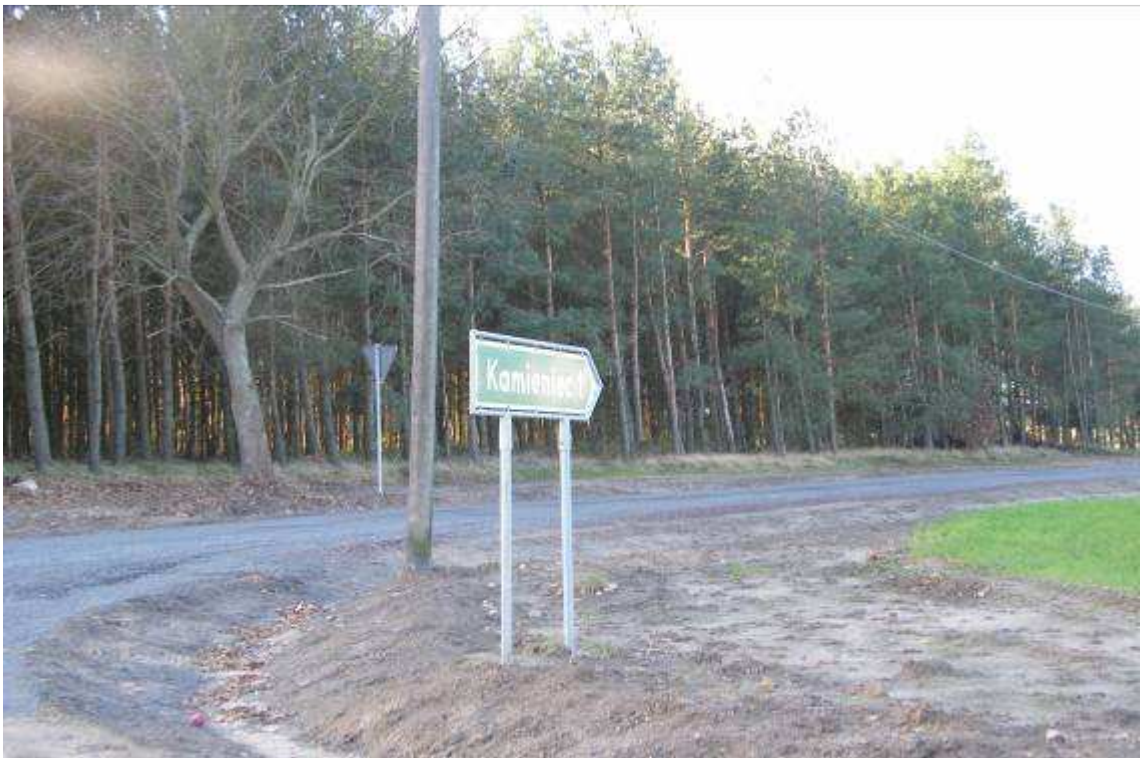
Fot. 37. Przebudowana droga do wsi Kamieniec
