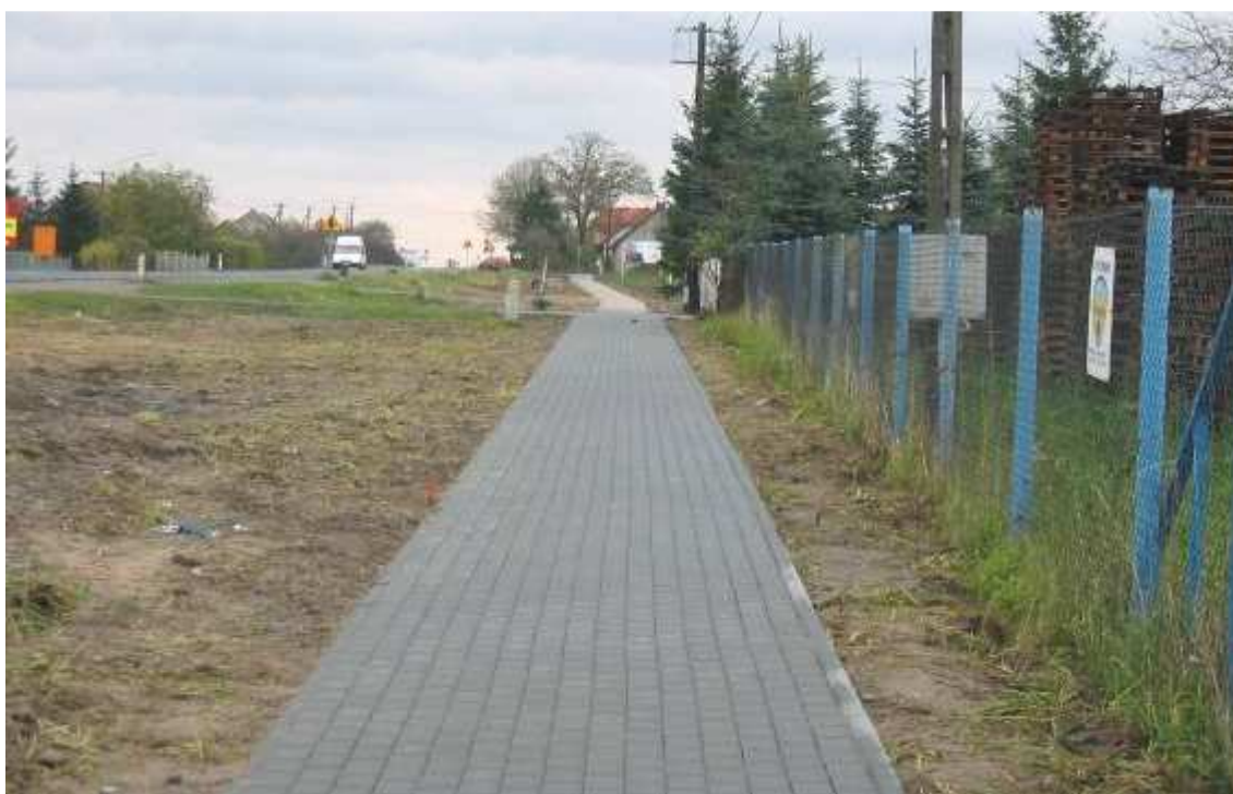
Fot. 31. Wybudowany chodnik przy drodze krajowej nr 10 w miejscowości Kruszyn
