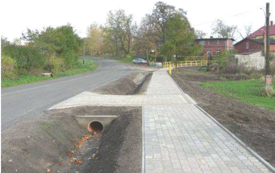
Fot. 32. Chodnik przy drodze powiatowej w miejscowości Trzemiętowo (widok wyremontowanej części chodnika i przepustu pod zjazdem)
