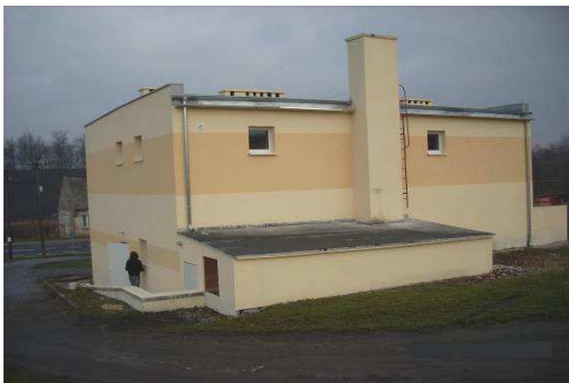
Fot. 49. Wyremontowany budynek WDK w miejscowości Strzelewo
