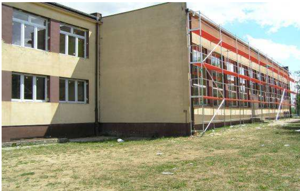
Fot. 42. Roboty budowlane (wymiana stolarki okiennej)
