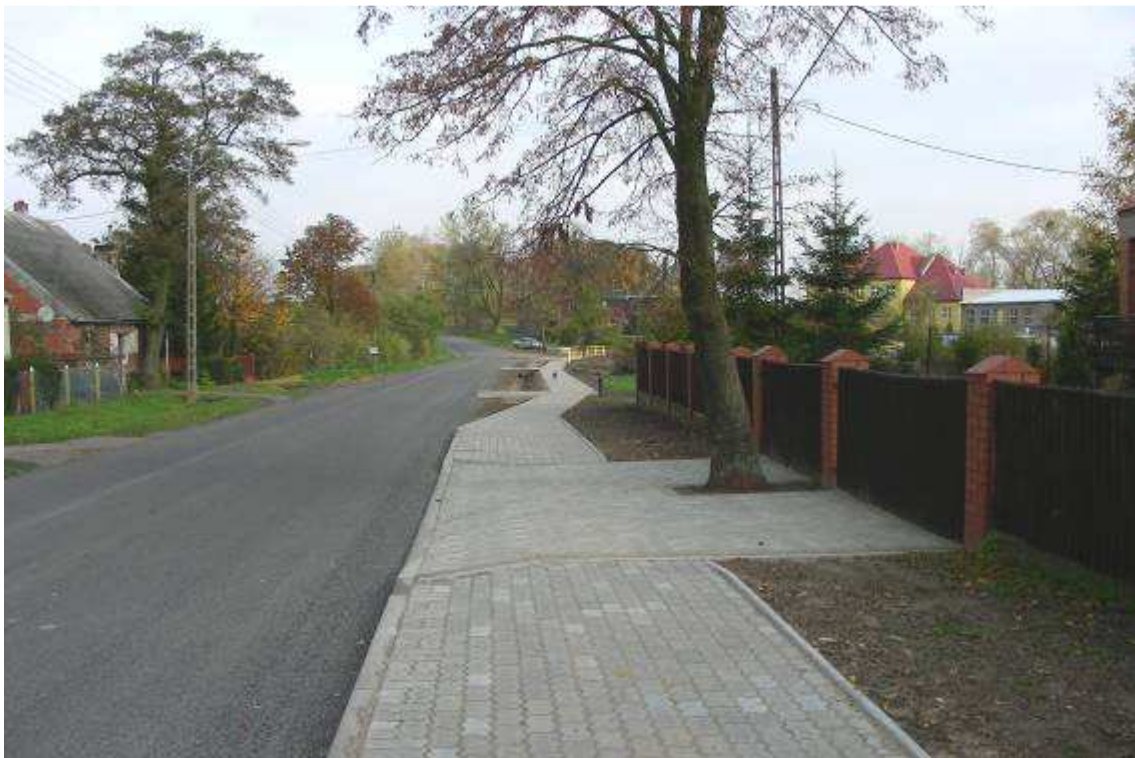
Fot. 33. Chodnik w miejscowości Trzemiętowo (widok na chodnik i zjazd)
