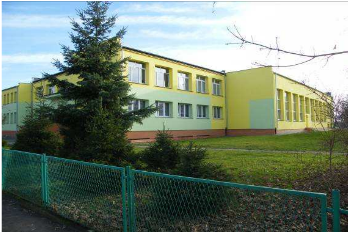
Fot. 44. Nowa elewacja budynku szkoły
