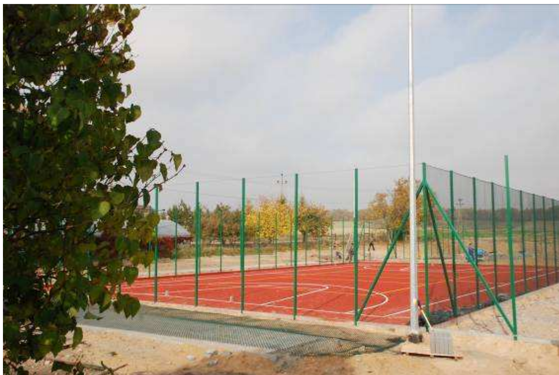
Fot. 55. Plac budowy (zdjęcie z realizacji, 13 października 2008r.)
