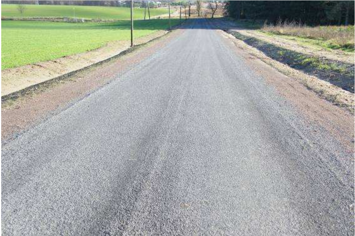
Fot. 36. Przebudowany odcinek drogi poprzez podwójne powierzchniowe utwardzenie nawierzchni tłuczniowej grysami i emulsją
