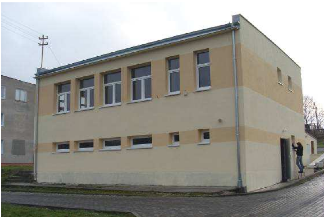
Fot. 48. Wyremontowany budynek WDK w miejscowości Strzelewo
