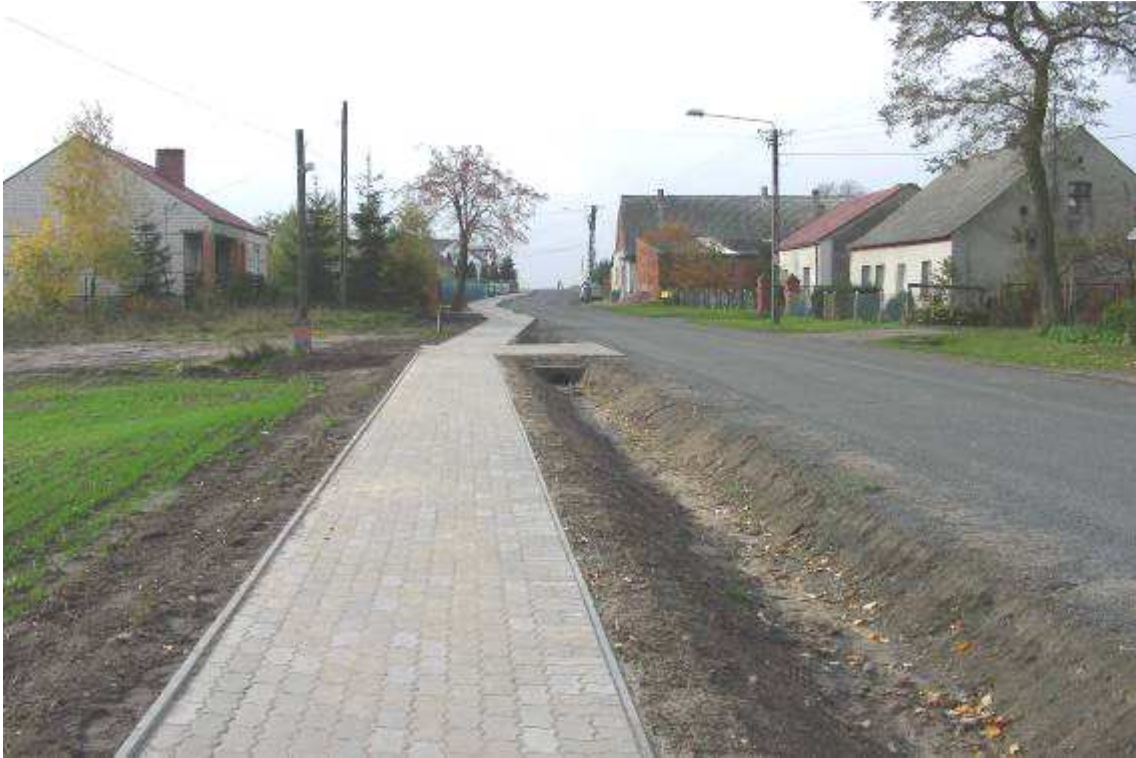
Fot. 34. Chodnik w przy drodze powiatowej w miejscowości Trzemiętowo (widok w kierunku domu dziecka)
