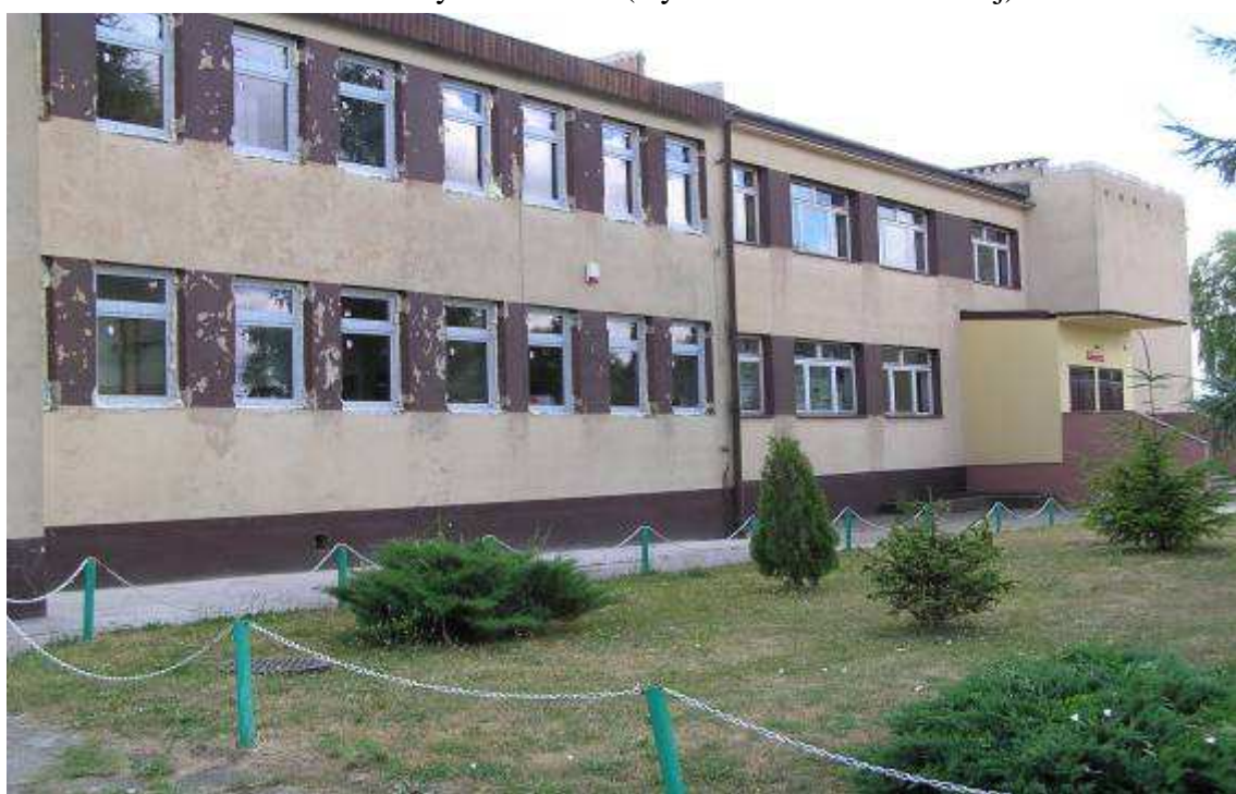
Fot. 43. Wymieniona stolarka okienna (widok od strony drogi)
