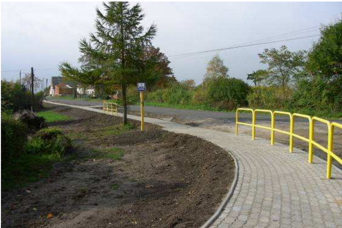
Fot. 35. Chodnik w przy drodze powiatowej w miejscowości Trzemiętowo
