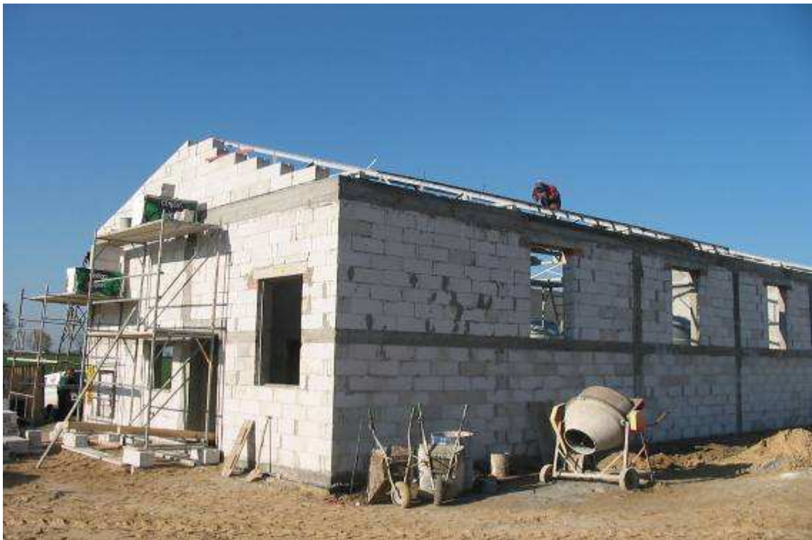
Fot. 4. Budowany budynek Stacji Uzdatniania Wody (etap montażu konstrukcji dachowej)
