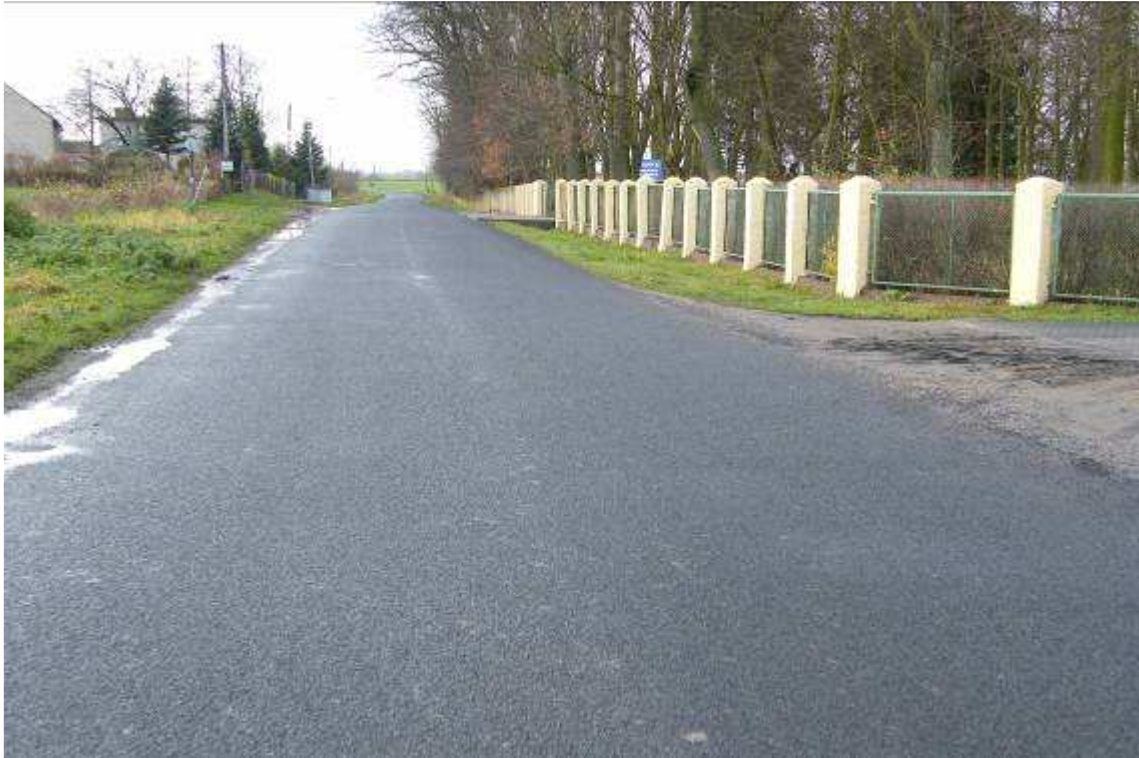
Fot. 28. Powierzchniowe utwalenie drogi powiatowej Krukówko – Witoldowo na docinku Gliszcz - Wierzchucinek
