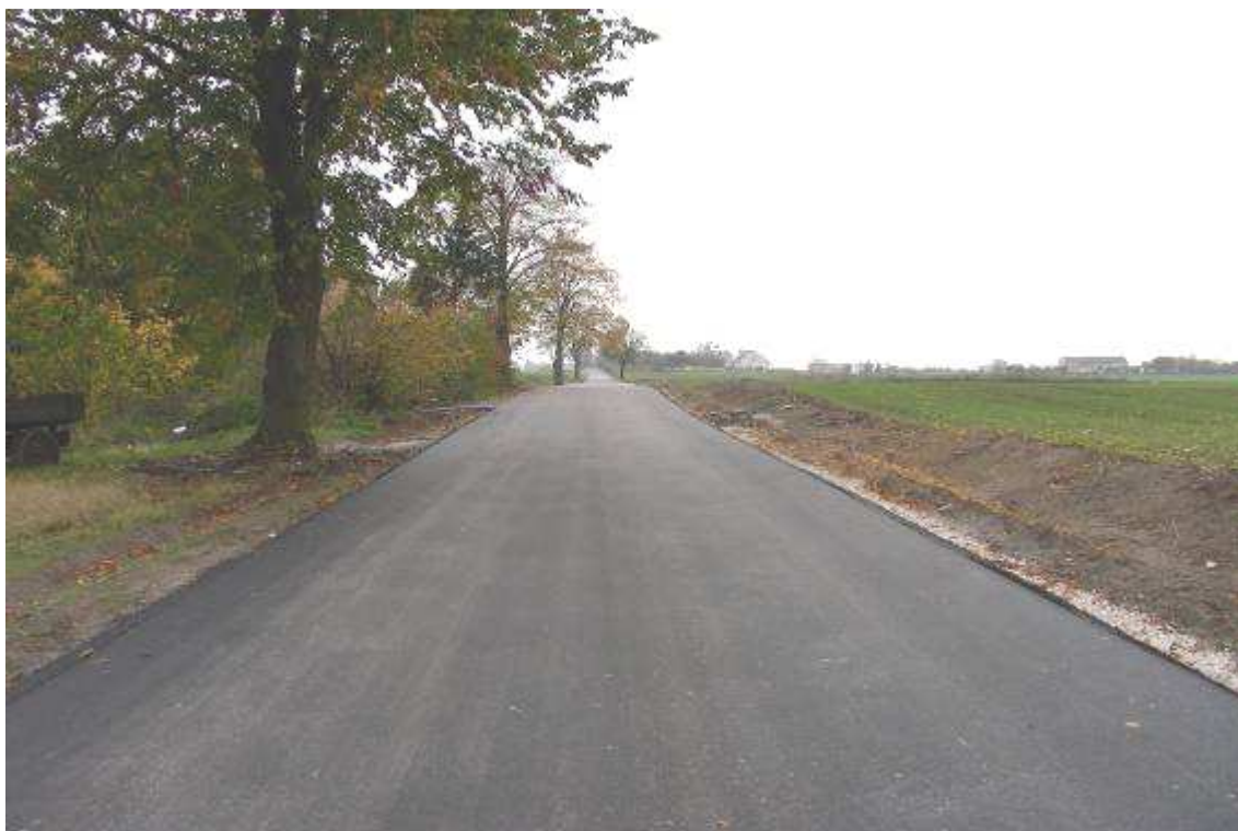
Fot. 20. Przebudowana droga gminna na odcinku Wojnowo – Chmielewo (widok w kierunku wsi Chmielewo)
