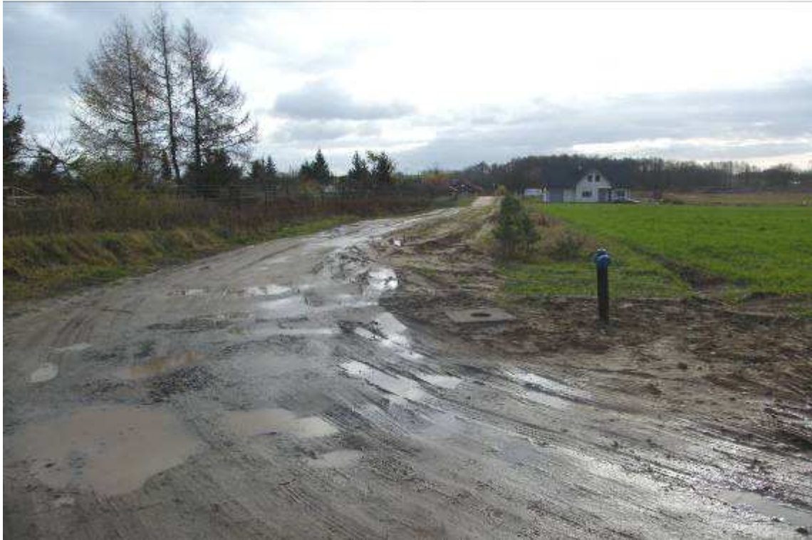
Fot. 14. Sieć wodociągowa (hydrant przeciwpożarowy)
