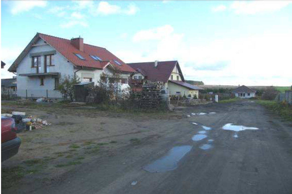
Fot. 7. Teren budowy wodociągu w miejscowości Osówiec
