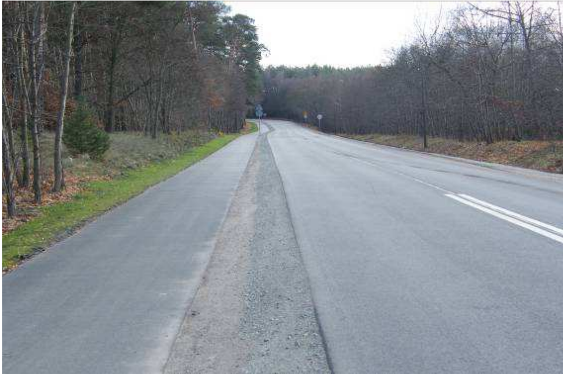
Fot. 22. Przebudowany odcinek drogi wraz ze ścieżką rowerową (widok w kierunku Osowej Góry)
