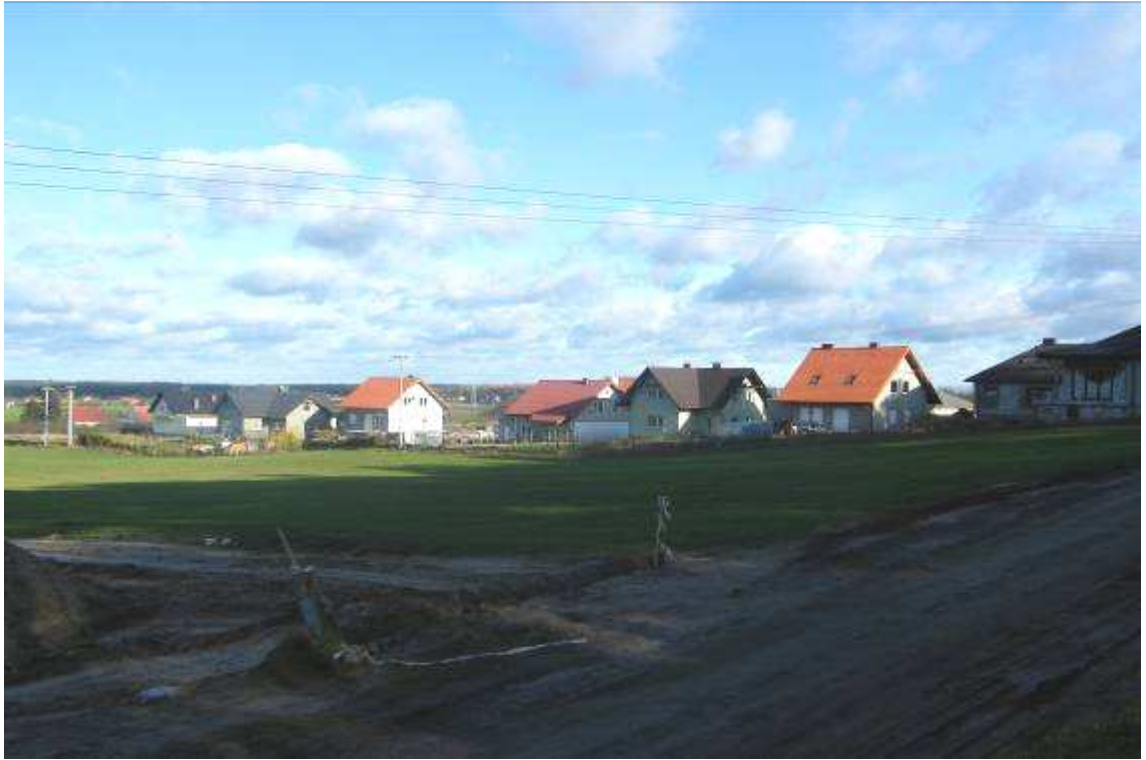
Fot. 13. Teren budowy wodociągu w miejscowości Kruszyn
