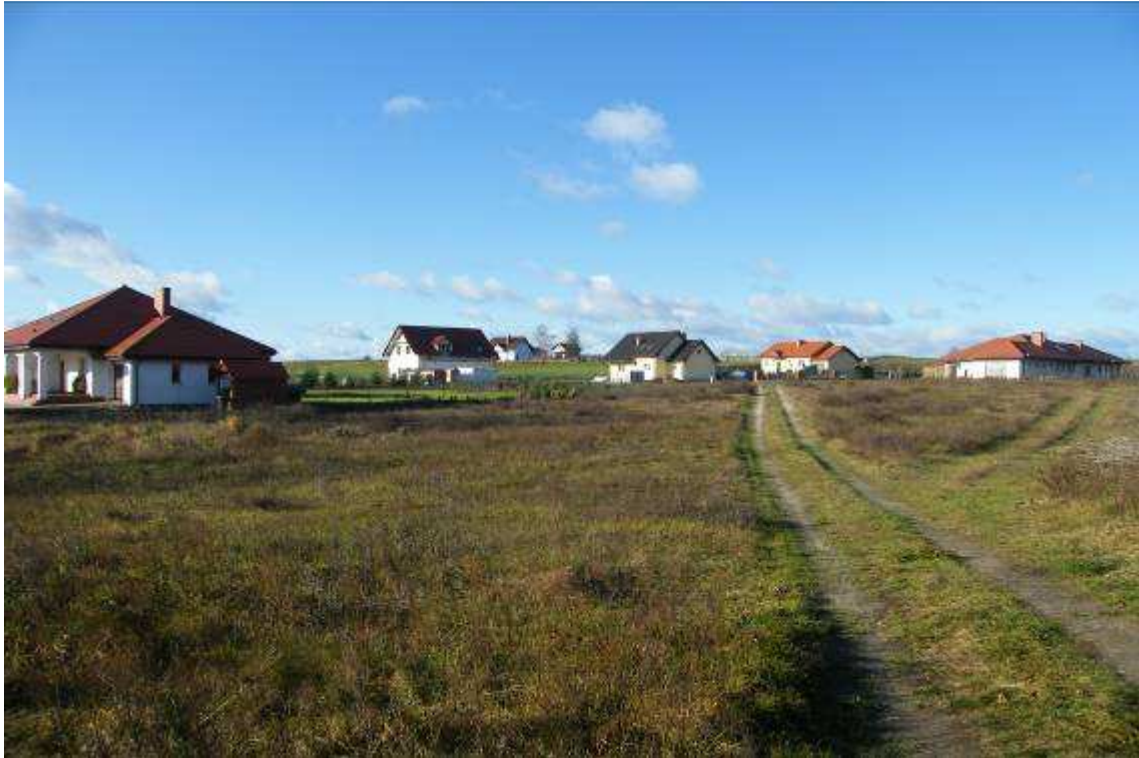
Fot. 9. Miejscowość Dąbrówka Nowa (teren budowy wodociągu)
