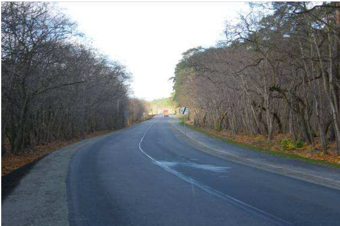
Fot. 23. Przebudowany odcinek drogi (widok w kierunku Osówca)
