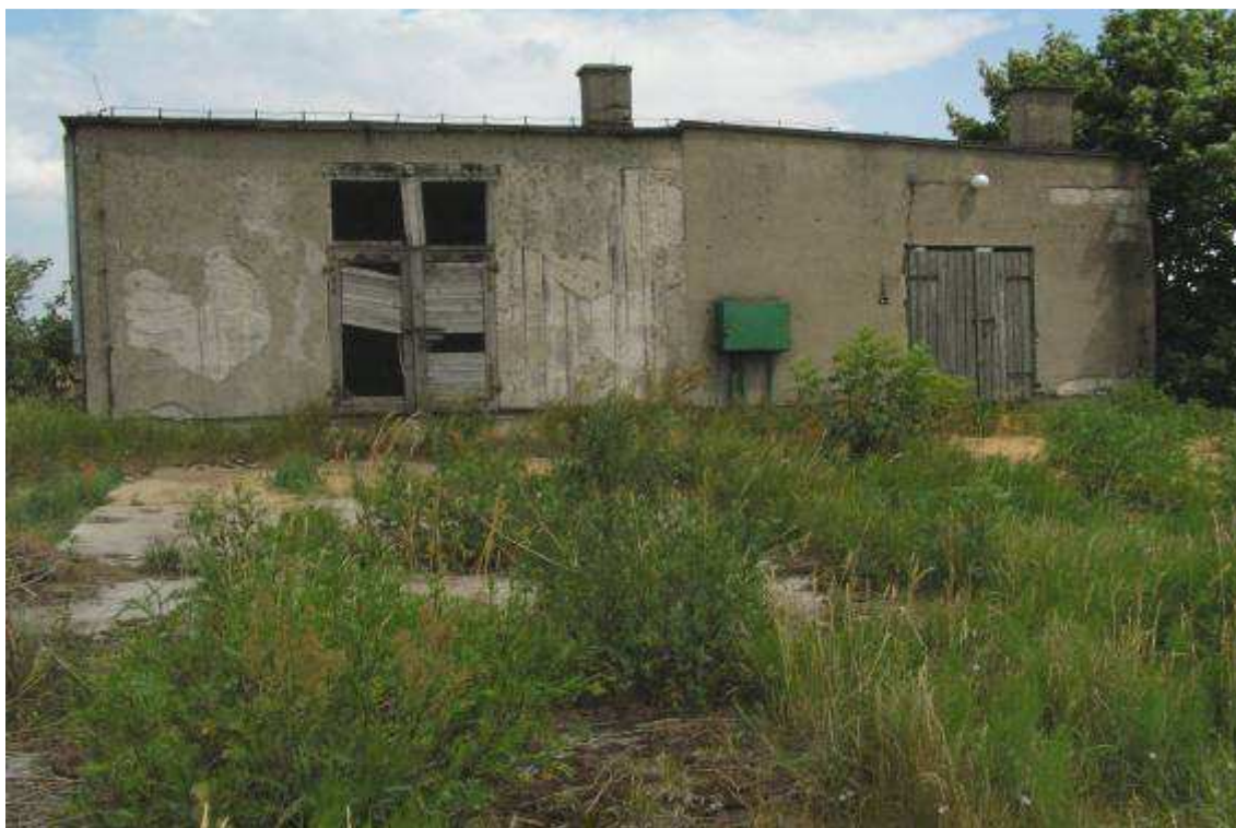
Fot. 1. Stacja Uzdatniania Wody (widok starego budynku, przed remontem)
