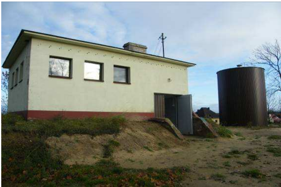
Fot. 17. Zbiornik retencyjny wody pitnej w miejscowości Kruszyn
