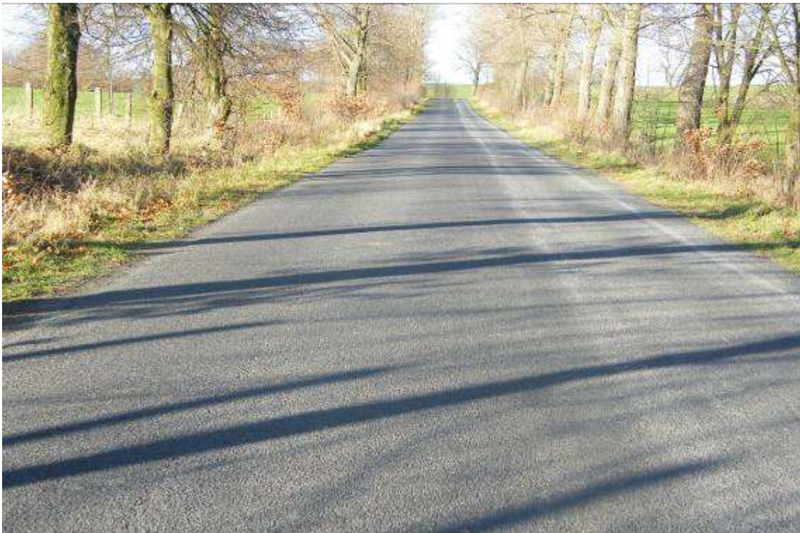
Fot. 29. Powierzchniowe utwalenie drogi powiatowej na odcinku Trzemiętówko - Sienko
