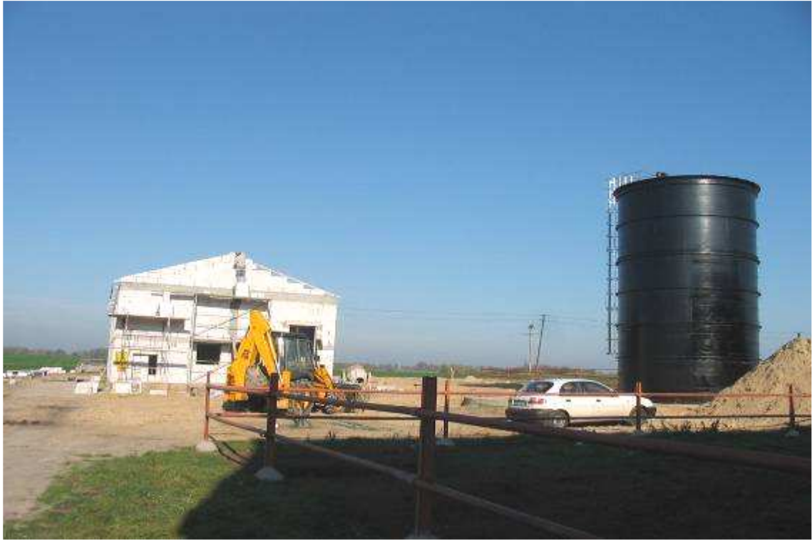
Fot. 3. Budowany zbiornik i budynek Stacji Uzdatniania Wody
