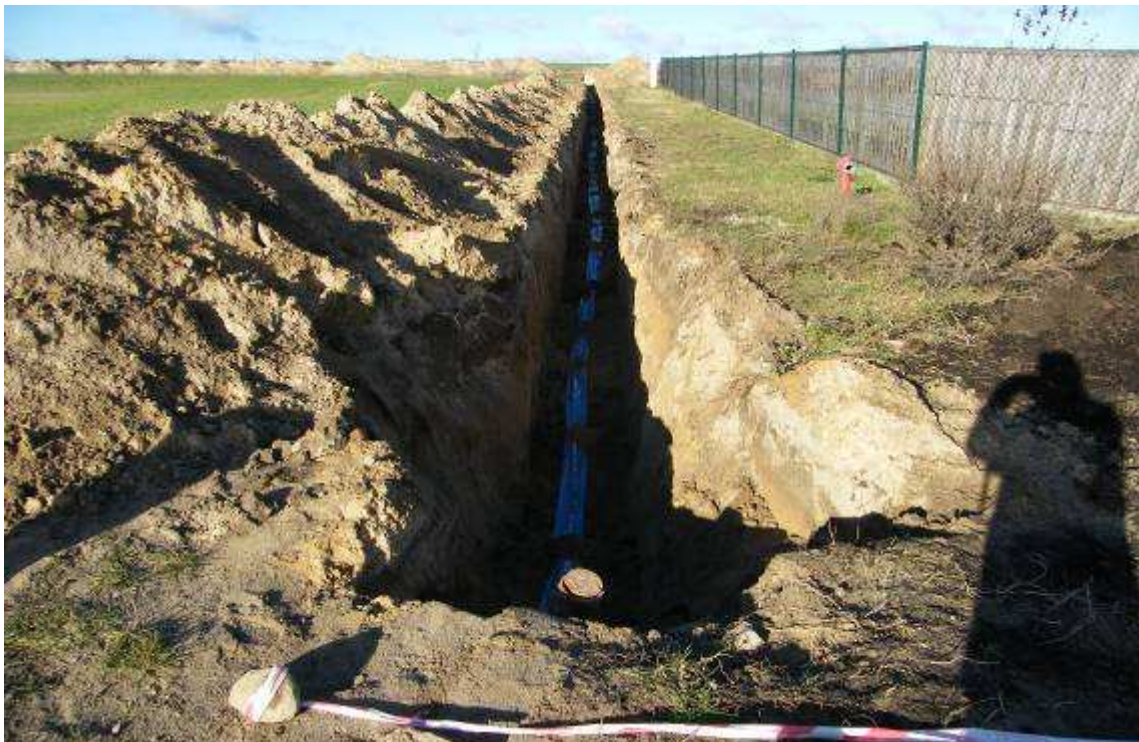
Fot. 10. Plac budowy - wodociąg w miejscowości Dąbrówka Nowa
