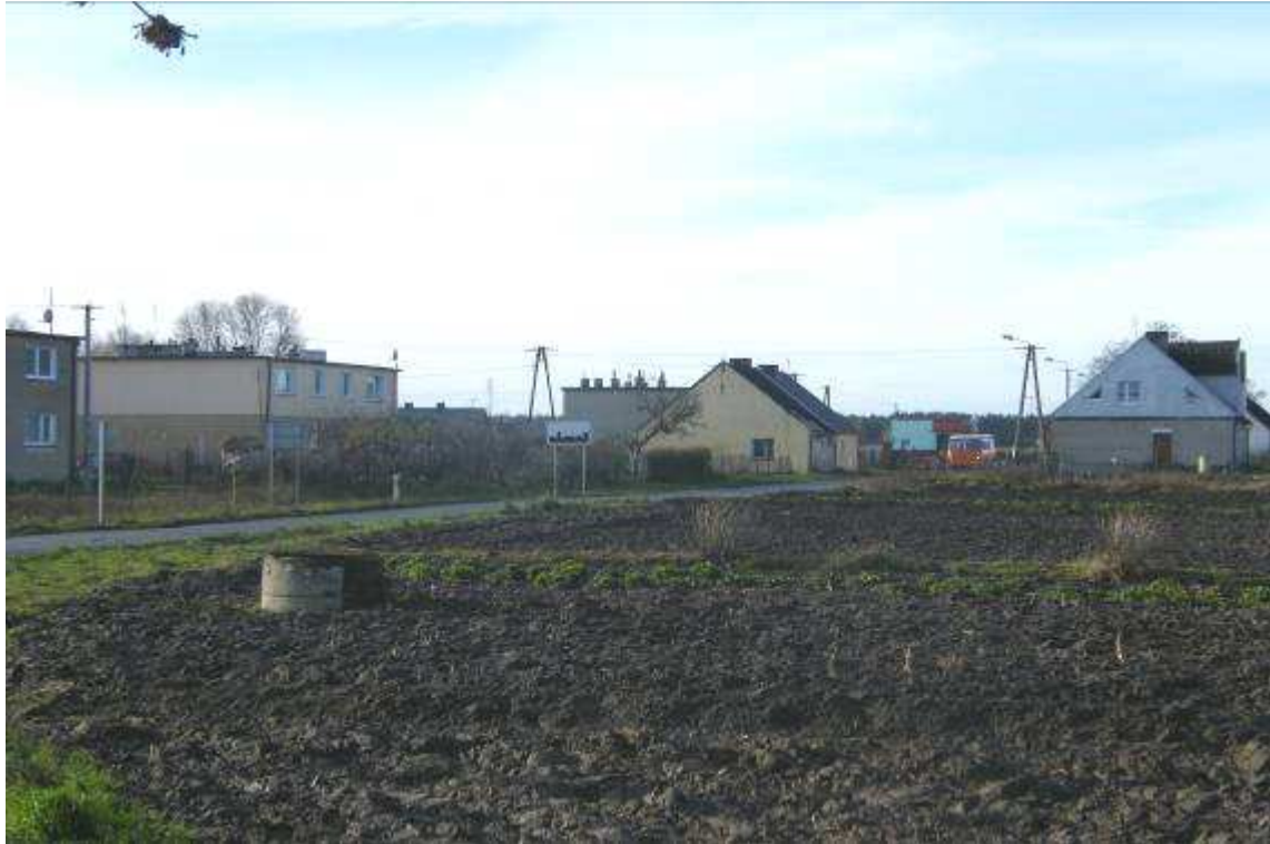
Fot. 11. Teren budowy sieci wodociągowej w miejscowości Słupowo
