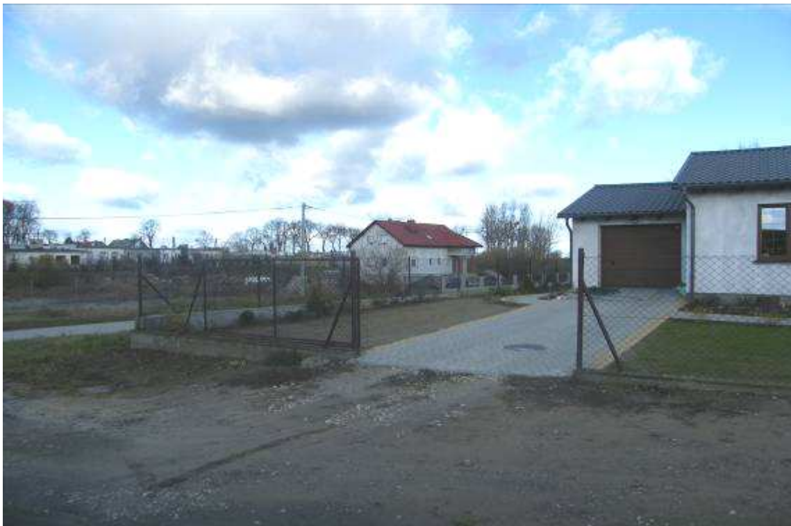
Fot. 8. Studzienka wodomierzowa
