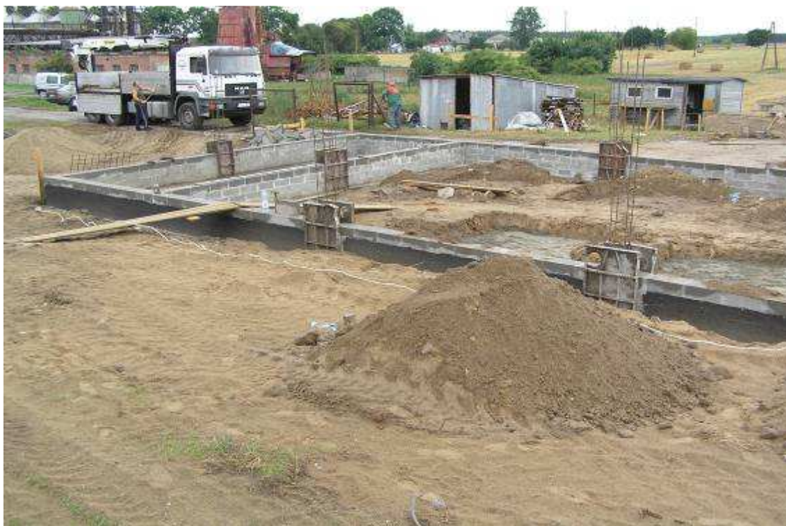
Fot. 2. Plac budowy (budowa nowego budynku S.U.W.)
