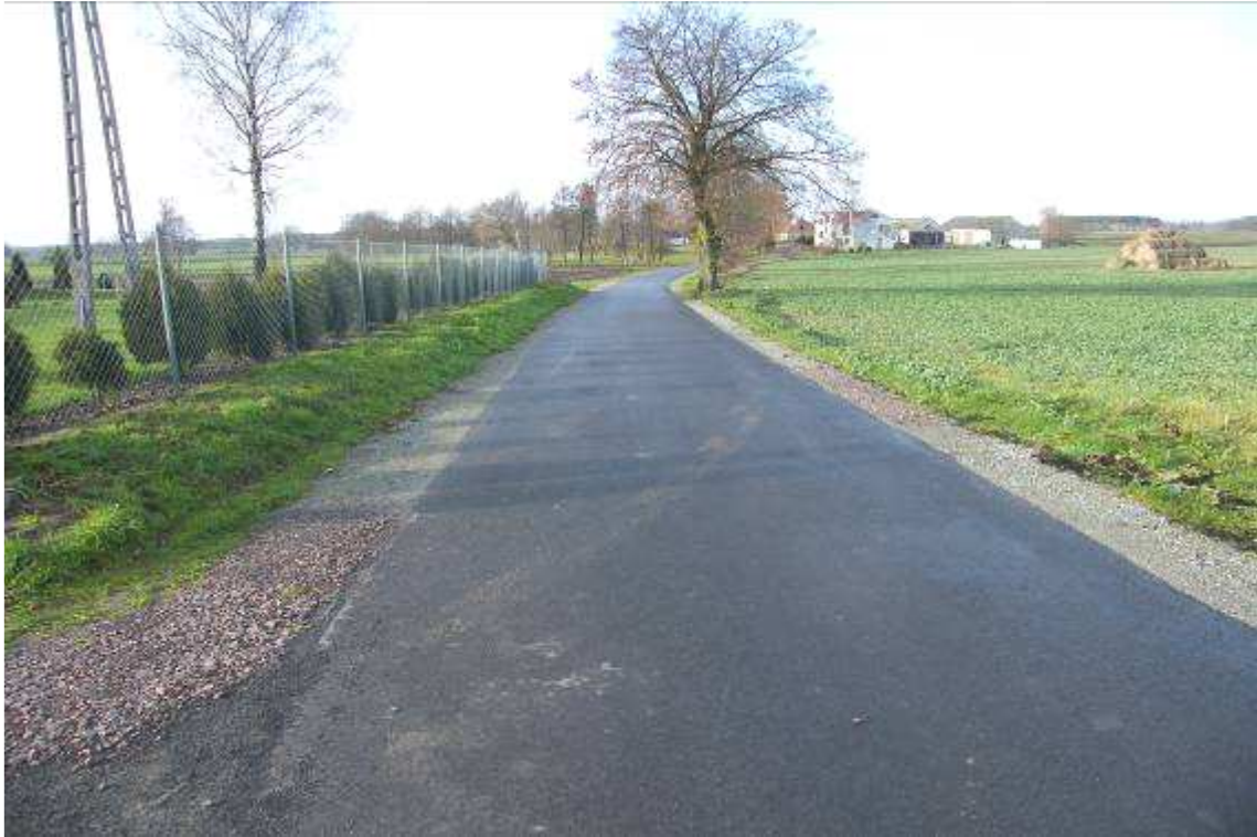
Fot. 26. Wyremontowana droga powiatowa Drzewianowo – Murucin
