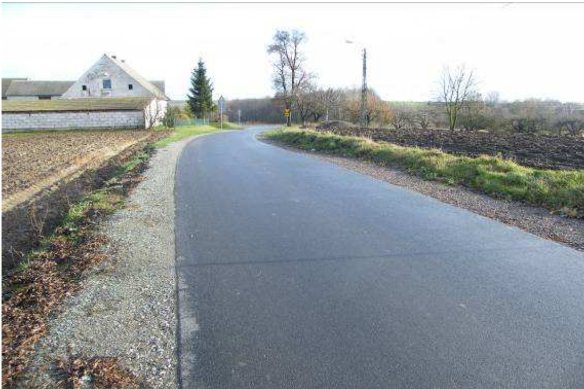
Fot. 27. Odcinek wyremontowanej drogi powiatowej Drzewianowo - Murucin
