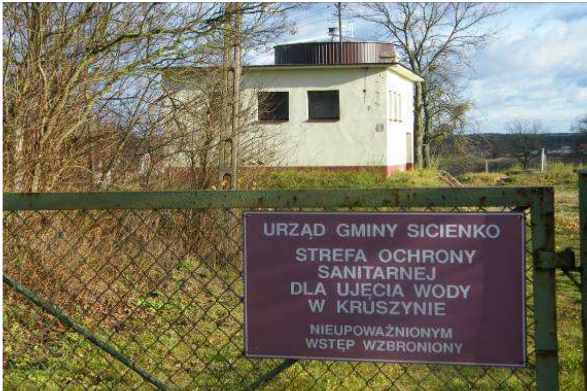
Fot. 16. Zbiornik retencyjny wody pitnej w miejscowości Kruszyn
