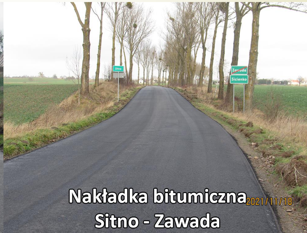
Nakładka bitumiczna 2021/11/18 Sitno - Zawada
