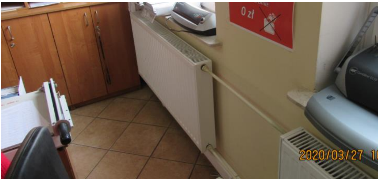
Zdjęcie nr 2 – Demontaż grzejnika wraz z rurami zasilającymi.
