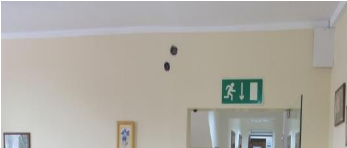
Zdjęcie nr 1 – Przeniesienie puszek elektrycznych tak aby nie kolidowały z planowaną lokalizacją ściany działowej
