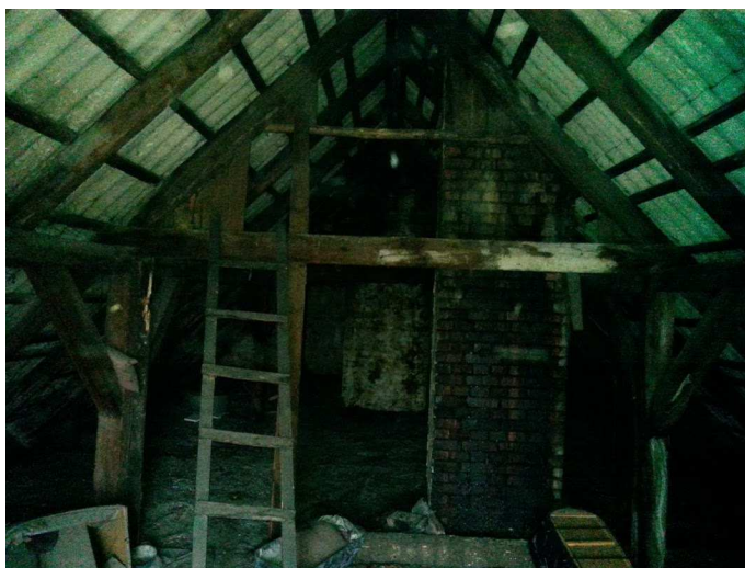
FOT. 3. WIDOK WIĘŻBY DACHOWEJ
