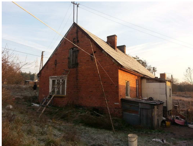
FOT. 2. ELEWACJA BOCZNA ORAZ TYLNA
